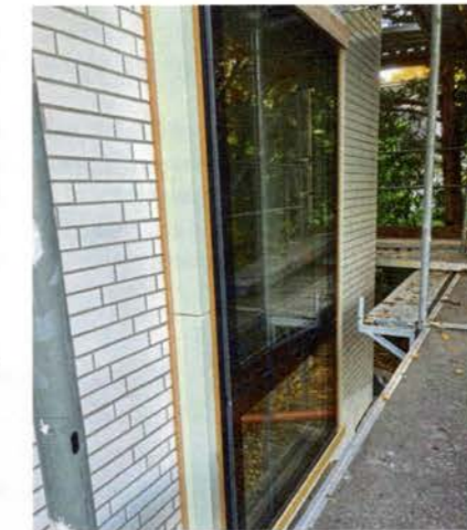
/ Für die Montage wurde das Vorwandmontagesystem Iso-Top Winframer „Typ 1“ von Iso-Chemie eingesetzt.
