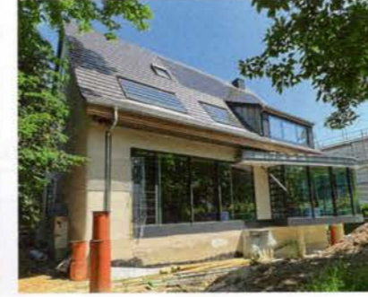
/ Ein klarer Baufortschritt ist zu erkennen: Die verschiedensten Fensterelemente sind schon eingebaut.
