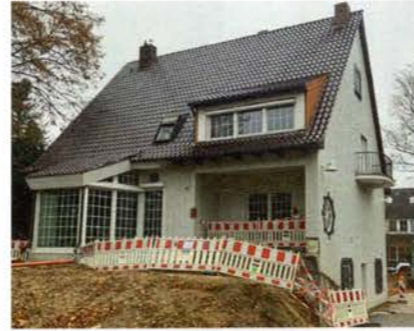
/ Das Einfamilienhaus vor der intensiven Sanierung: Eine gute Grundsubstanz macht dies erst möglich.
