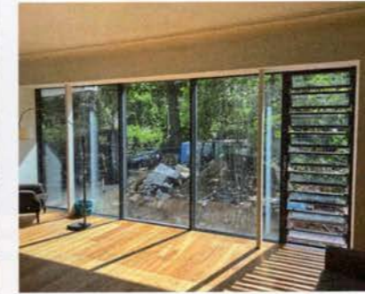
/ Die bodentiefen Fenster sorgen für viel Tageslicht und die Lamellenfenster (r.) für eine natürliche Lüftung.
