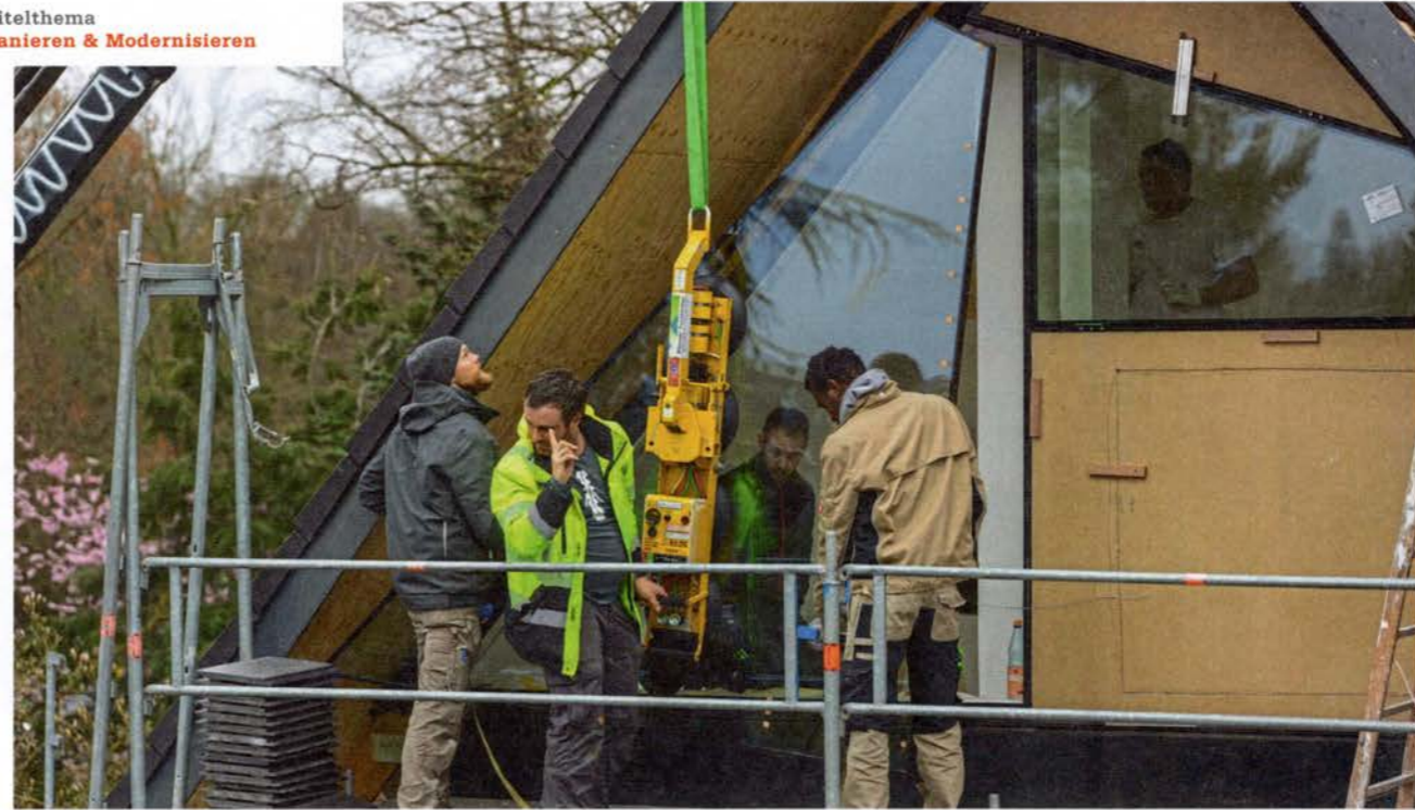
! Um die besonderen und großformatigen Verglasungen an der richtigen Stelle zu positionieren, gibt Geschäftsführer Heiko Siegmann (Mitte, gelbe Weste) dem Kranführer hilfreiche Kommandos.
